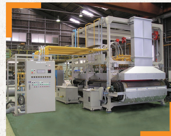
様々な熱処理炉を自社グループ内で設計施工 自社生産設備も自社で開発する。
