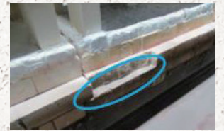
通常（上）の炉の状態と比較すると、炉内の温度が低くなっているところにはレンガの欠損など（下）何らかの不具合が起きていたことが分かった。
